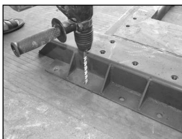
Fig. 3-A, B, C Verankering van de bodemplaat
