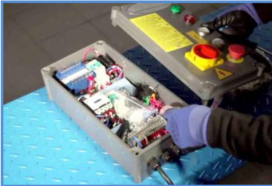
**Retire con cuidado la bolsa con el cable múltiple y el interruptor final de carrera. Abra la unidad de control y retire los tornillos de montaje y las bridas para cables. Abra la bolsa con el cable múltiple y el interruptor final de carrera.**
