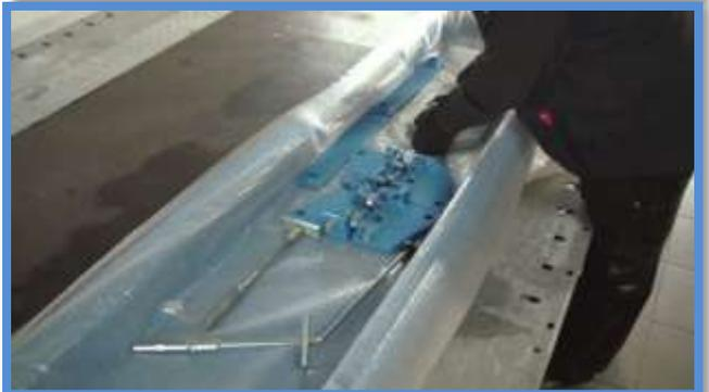
Una vez retiradas estas piezas, debería ser posible sacar sin problemas las columnas del bastidor de transporte.
