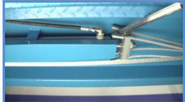
**A continuación, con una palanca de montaje, soltamos el cilindro debajo del carril principal, para poder extraer los cables del elevador más fácilmente.**
